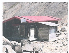
〔事例〕 那須岳山腹の避難小屋
